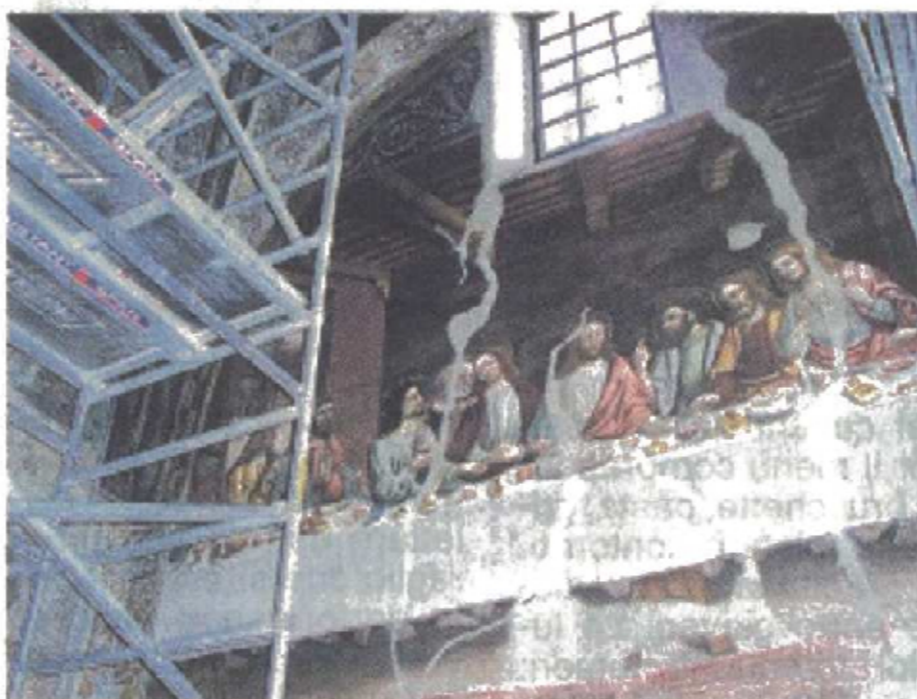
Lavori in corso all'interno della Cappella Marchionale
